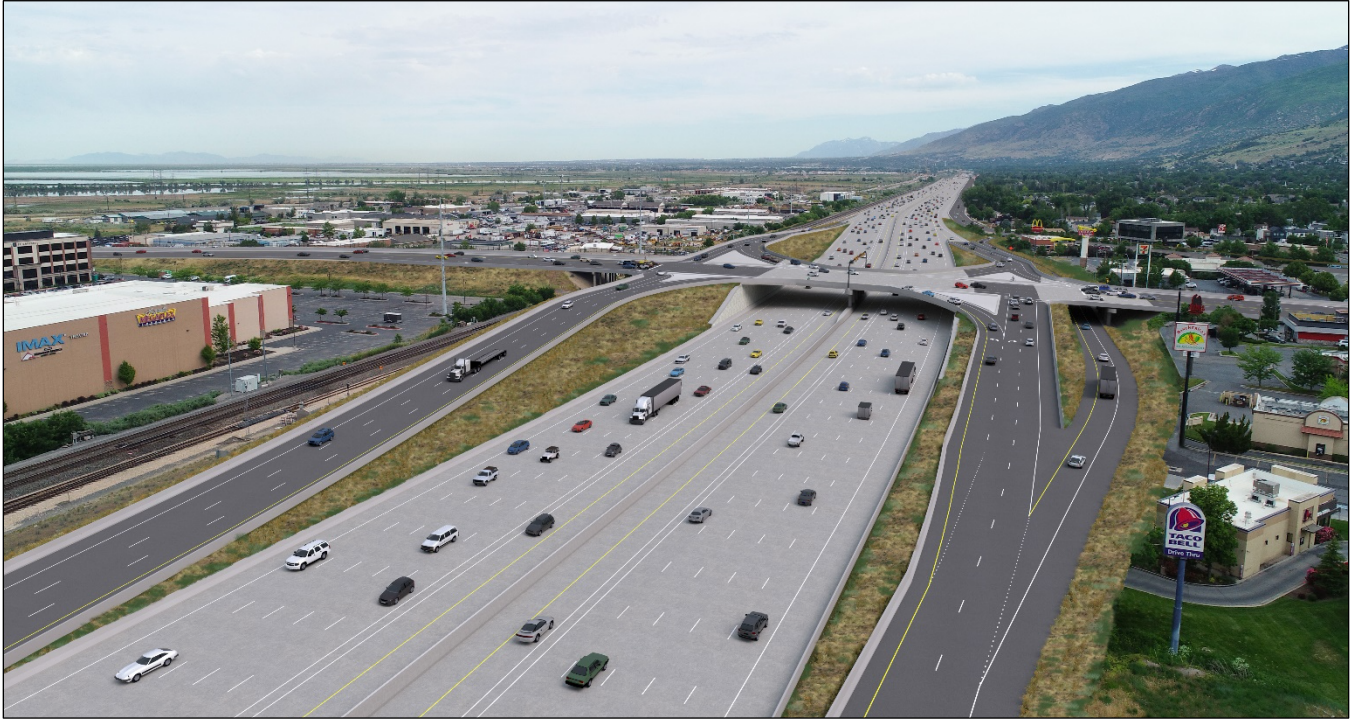
Figura 3.1516. Vista clave 3 mirando con simulación de la Alternativa de Acción en el intercambio vial de Parrish Lane y la I-15.
