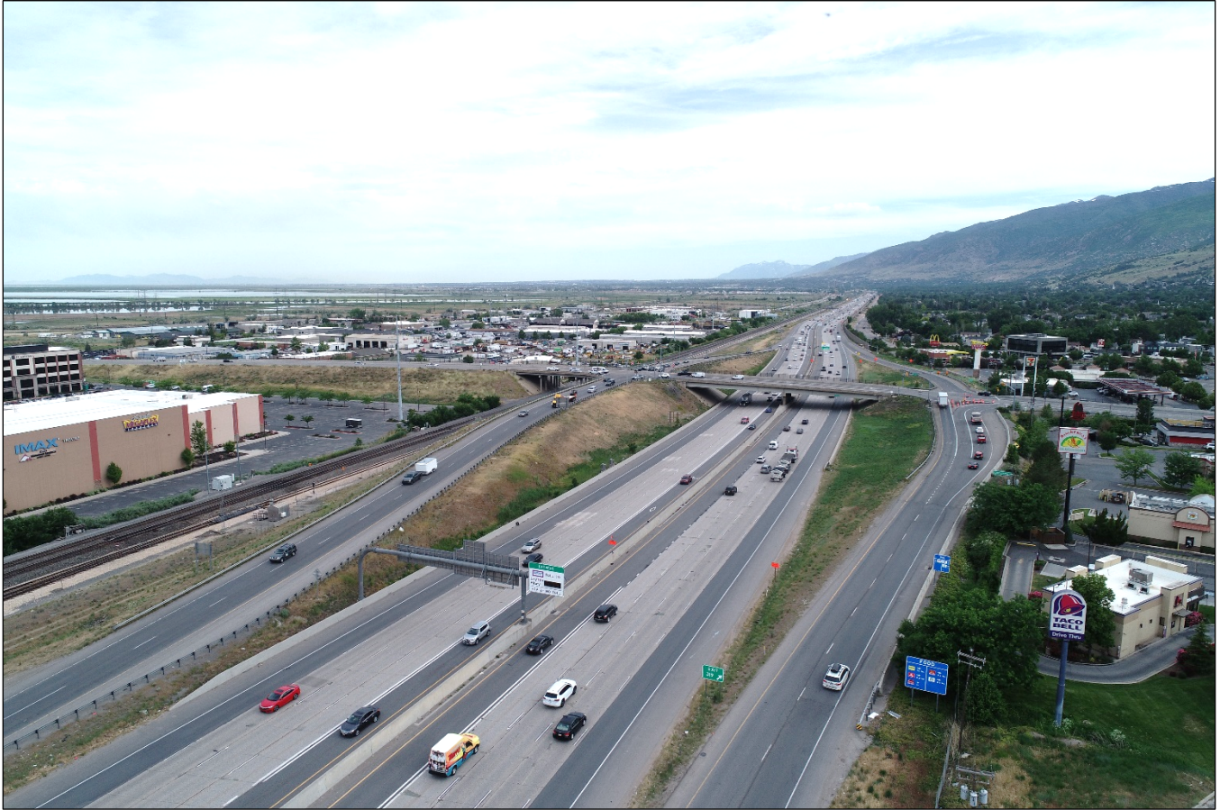
Figura 3.15-10. Vista clave 3 mirando hacia el norte por encima del intercambio vial de Parrish Lane y la I-15.
