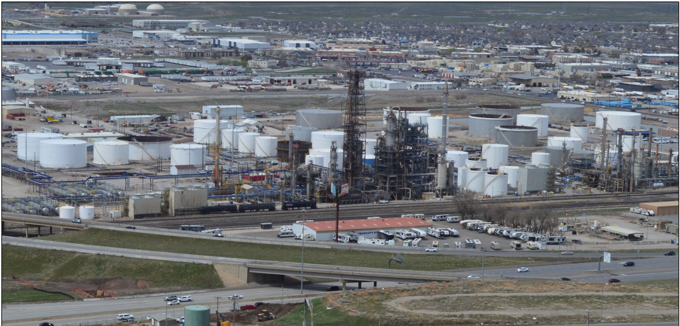
Figura 3.152. Área industrial al oeste de la I-15 en North Salt Lake
