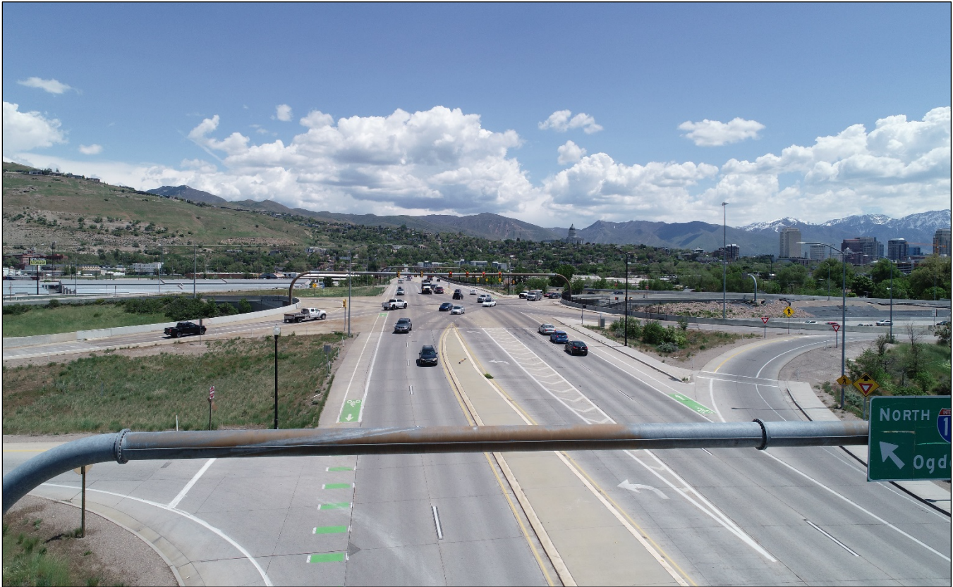
Figura 3.15-14. La vista clave 7 mirando hacia el este por encima de 600 North y el intercambio vial de la I-15 en Salt Lake City.
