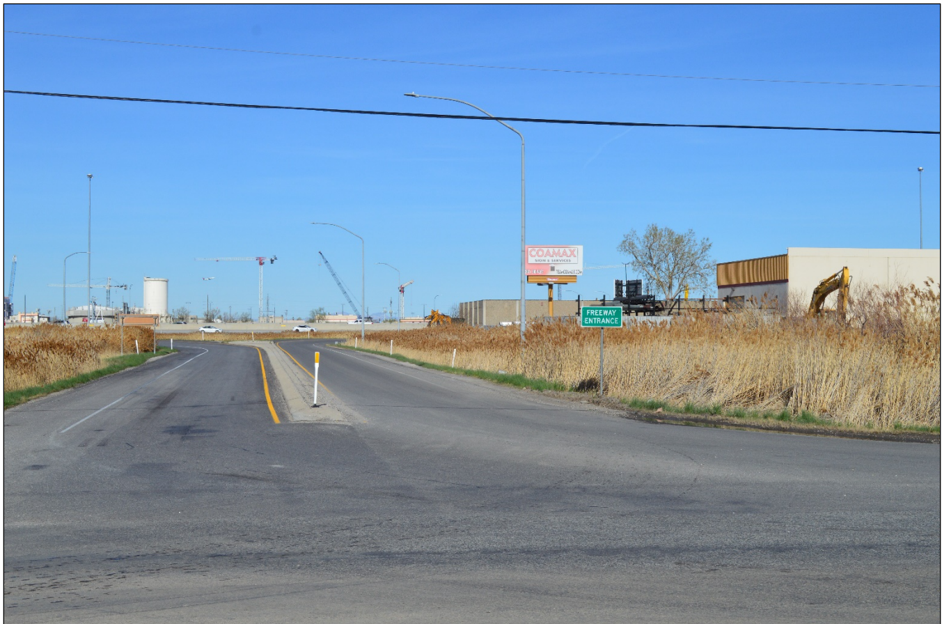
Figura 3.1513. Vista clave 6 mirando hacia el oeste, a la rampa de acceso/salida de 2100 North en Salt Lake City
